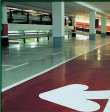
Otorga a los pavimentos de hormigón, cemento y derivados un acabado decorativo y resistente a la abrasión y agresión química, facilitando además su limpieza al evitar la formación de polvo por erosión de su superficie. Indicado su uso en PÁRKINGS, NAVES INDUSTRIALES, GARAJES, BODEGAS, etc...
